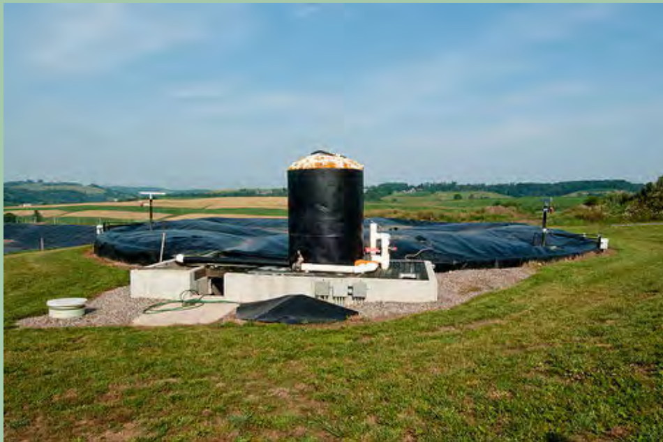
'n Degradeerder wat gebruik word om mis te ontbind om metaangas te vervaardig.
