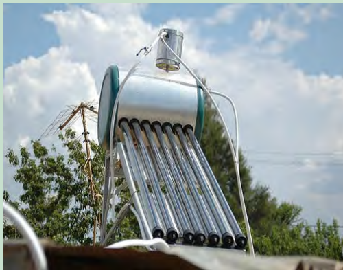
'n Nabyskoot van 'n sonkragwaterverwarmer.
