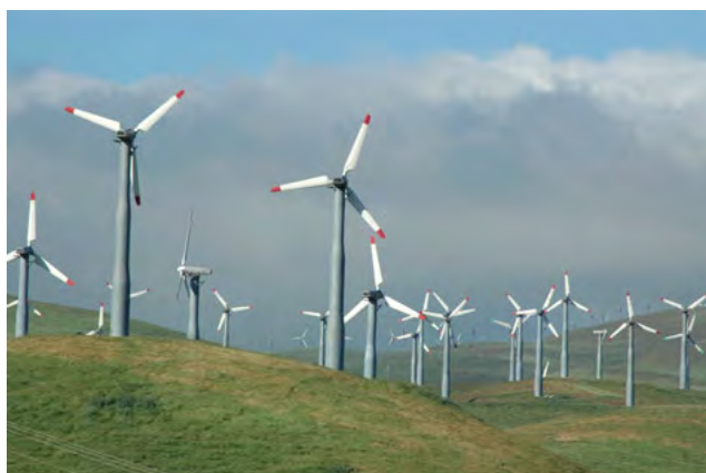
Windturbines gebruik wind om elektrisiteit op te wek.
