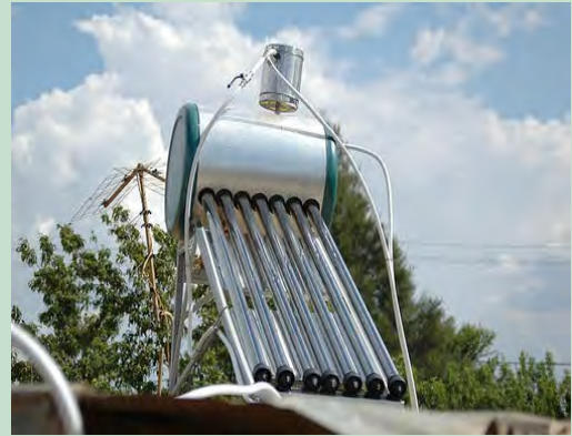
'n Nabyskoot van 'n sonkragwaterverwarmer.
