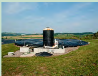
Biobrandstof - 'n Degradeerder wat gebruik word om mis te ontbind om metaangas te vervaardig.
