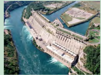
Hidrokrag - 'n Groot hidro-elektriese kragstasie.
