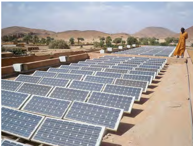
Sonpanele op 'n dak.
