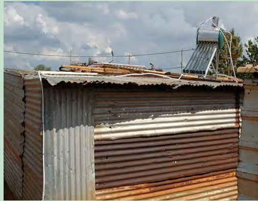
'n Sonkragwaterverwarmer bo-op 'n sinkhuis.
